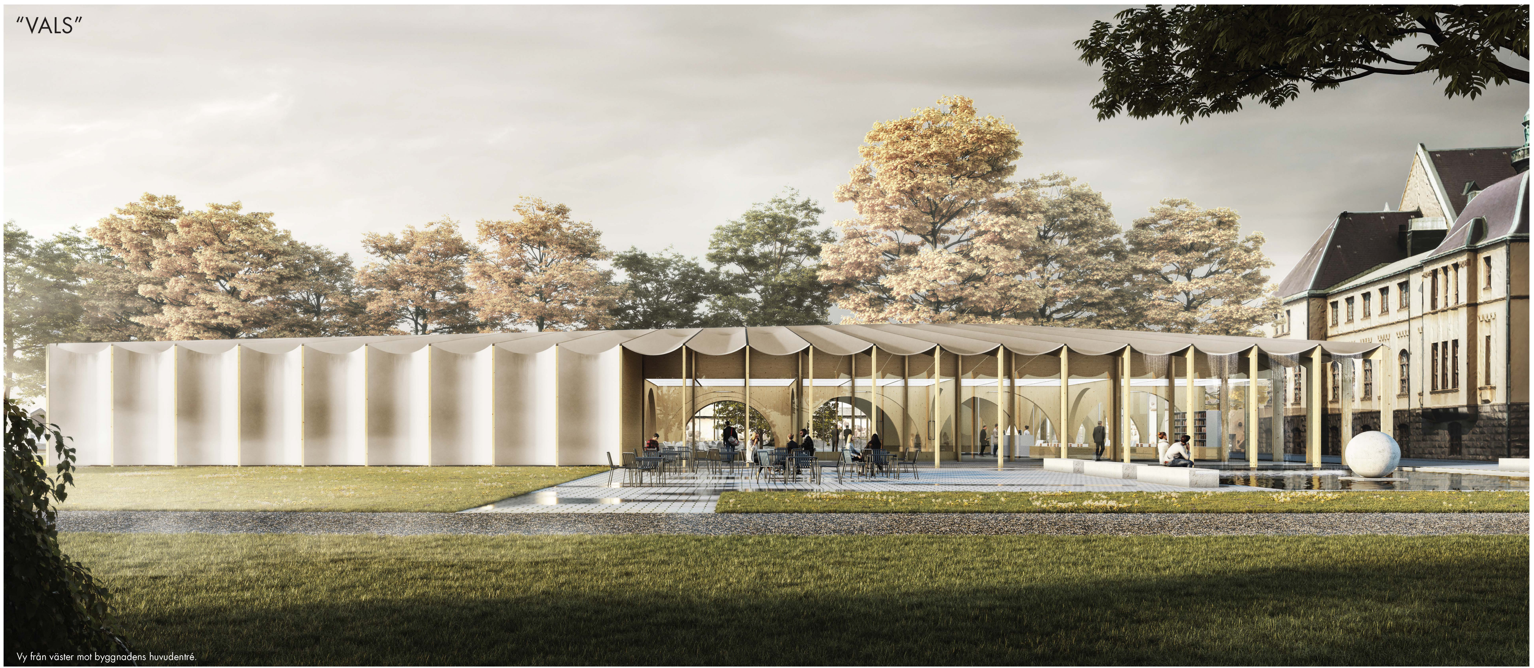
Vy från väster mot byggnadens huvudentré.
