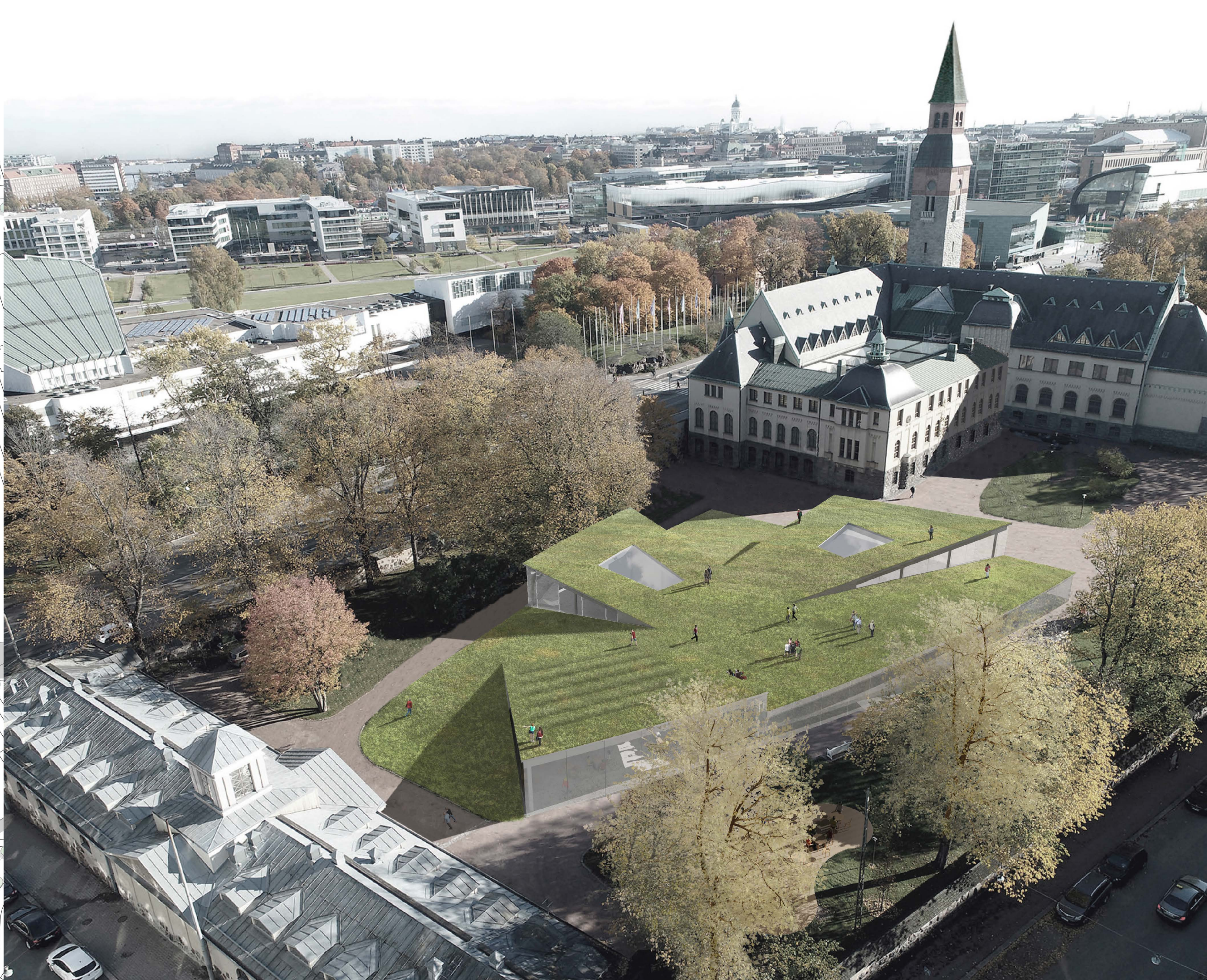
Kansallismuseon lisärakennus luoteesta kuvattuna
