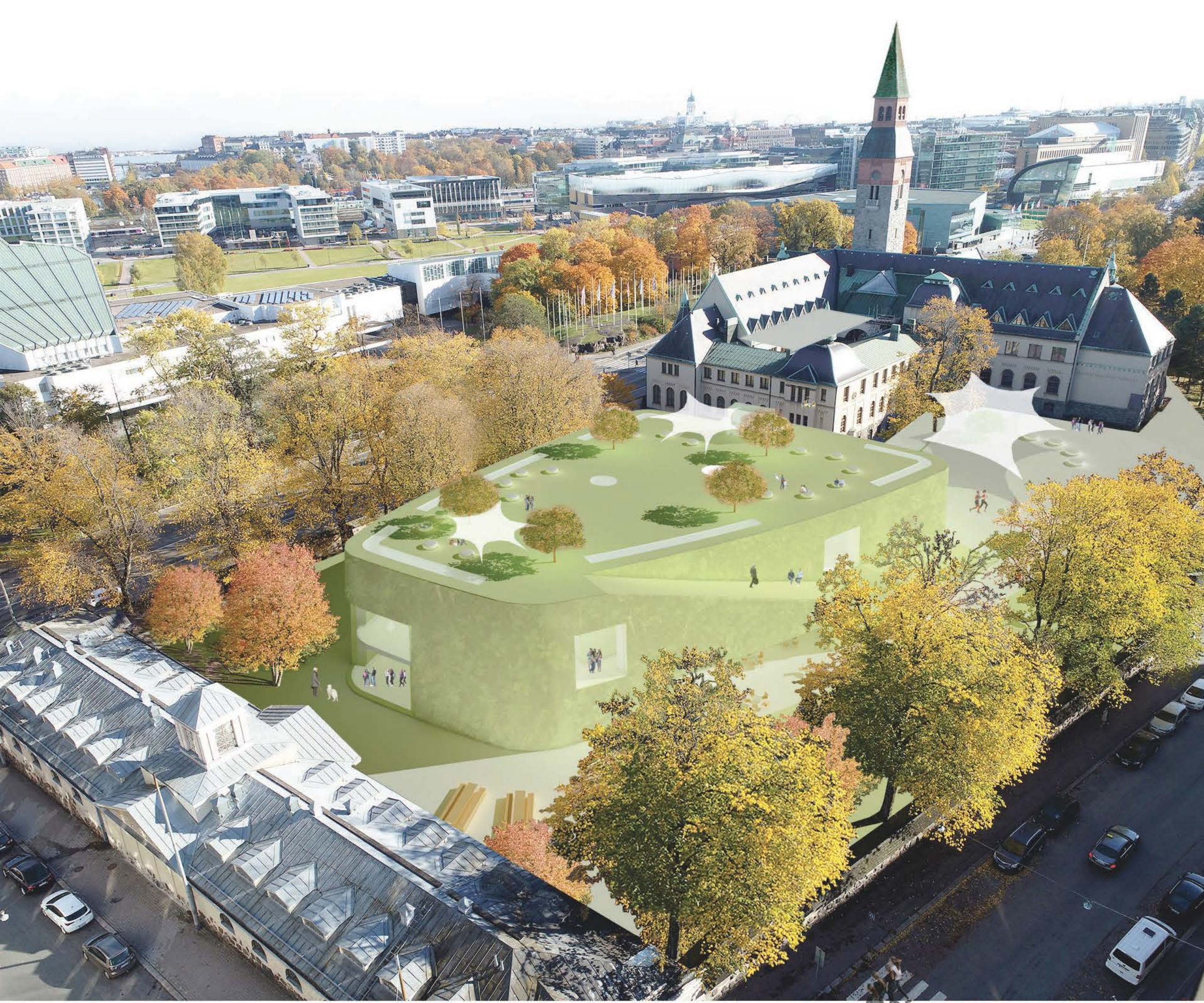
PUISTOPAVILJONKI ON TOIMINNALLINEN OSA PUUSTOA - KASVILLISUUDEN VERHOAMA JULKISIVU ON OSA RAKENNUKSEN ILMASTORATKAISUA
